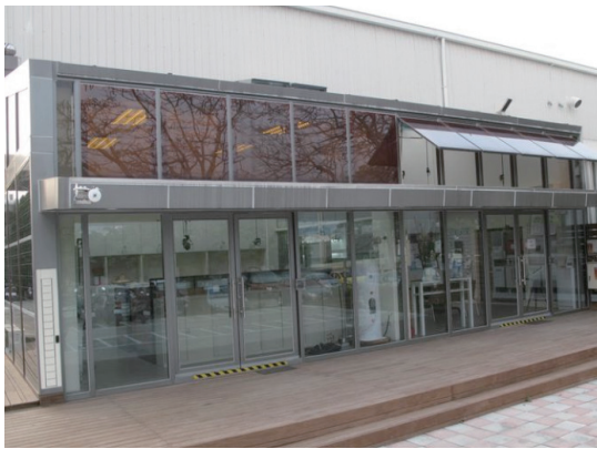
圖 3、BIPV 窗戶應用案例 - 工研院 46 館 BIPV 實驗展示屋
