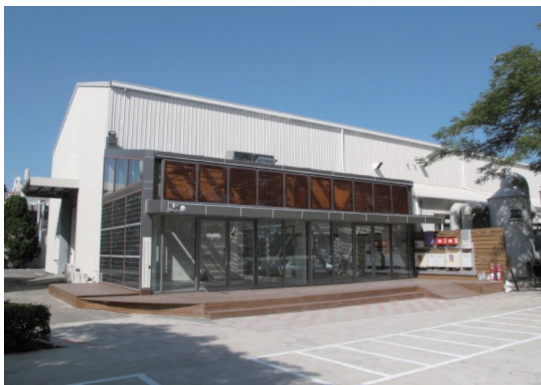
圖 8、BIPV 各面向模組，依序為 BIPV 斜屋頂、BIPV 立面牆、BIPV 氣窗、BIPV 雨遮
