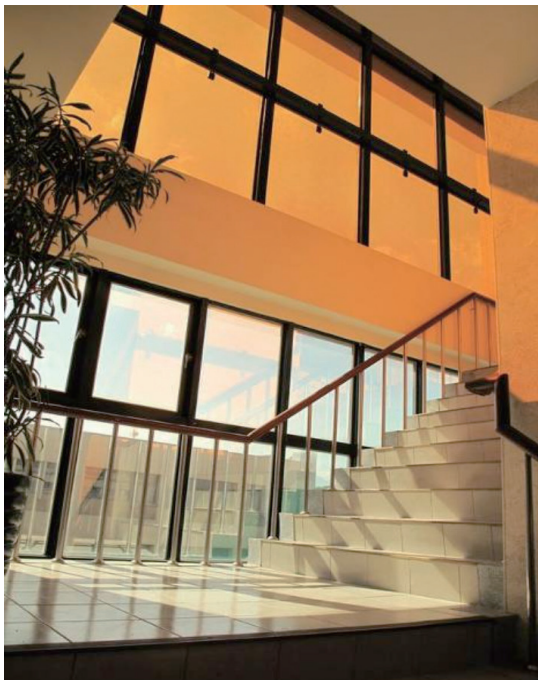
圖 3、BIPV 窗戶應用案例 - 工研院 46 館 BIPV 實驗展示屋
