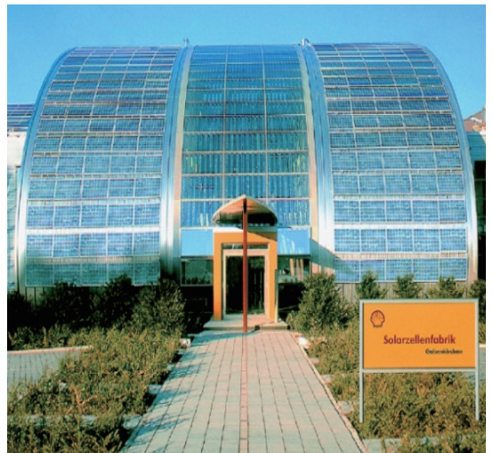
圖 4、BIPV 玻璃帷幕牆應用案例 - 工研院 10 館 IEK 辦公室 (左)、原德國 Shell Solar 公司太陽電池廠 (右)
